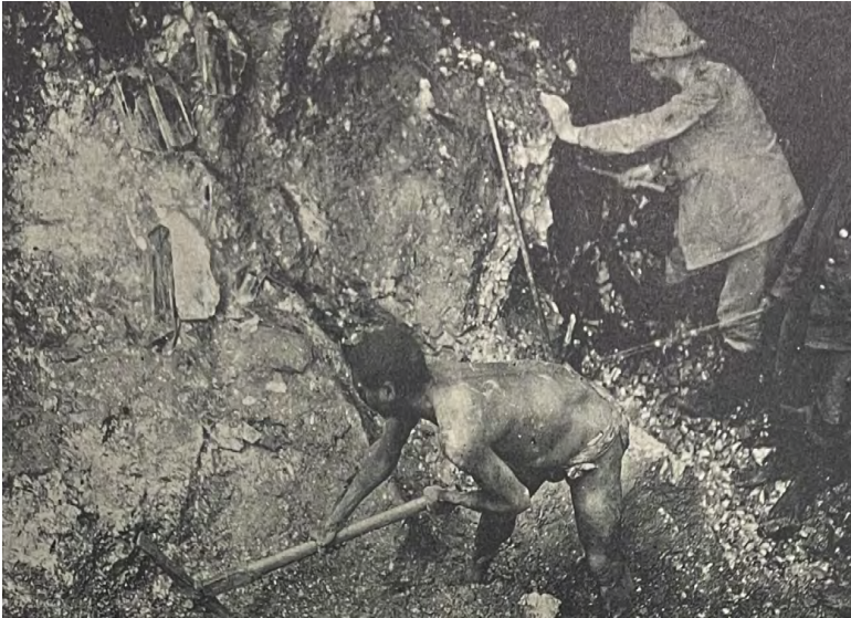
Abb. 15-16: Glimmerberg bei Essudan (Bezirk Ossidinge) in Kamerun um 1909. Pegmatitgang mit Muskovit-Führung, Abbau von Glimmertafeln.
